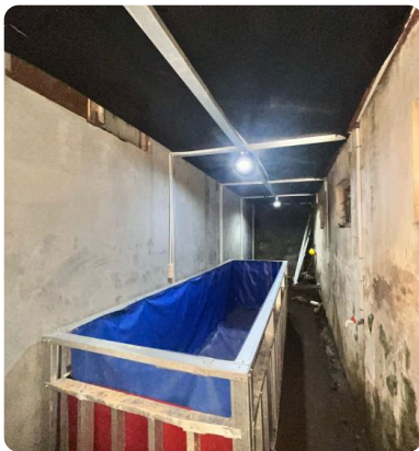
Pembangunan Kolam & Pendampingan Budidaya
